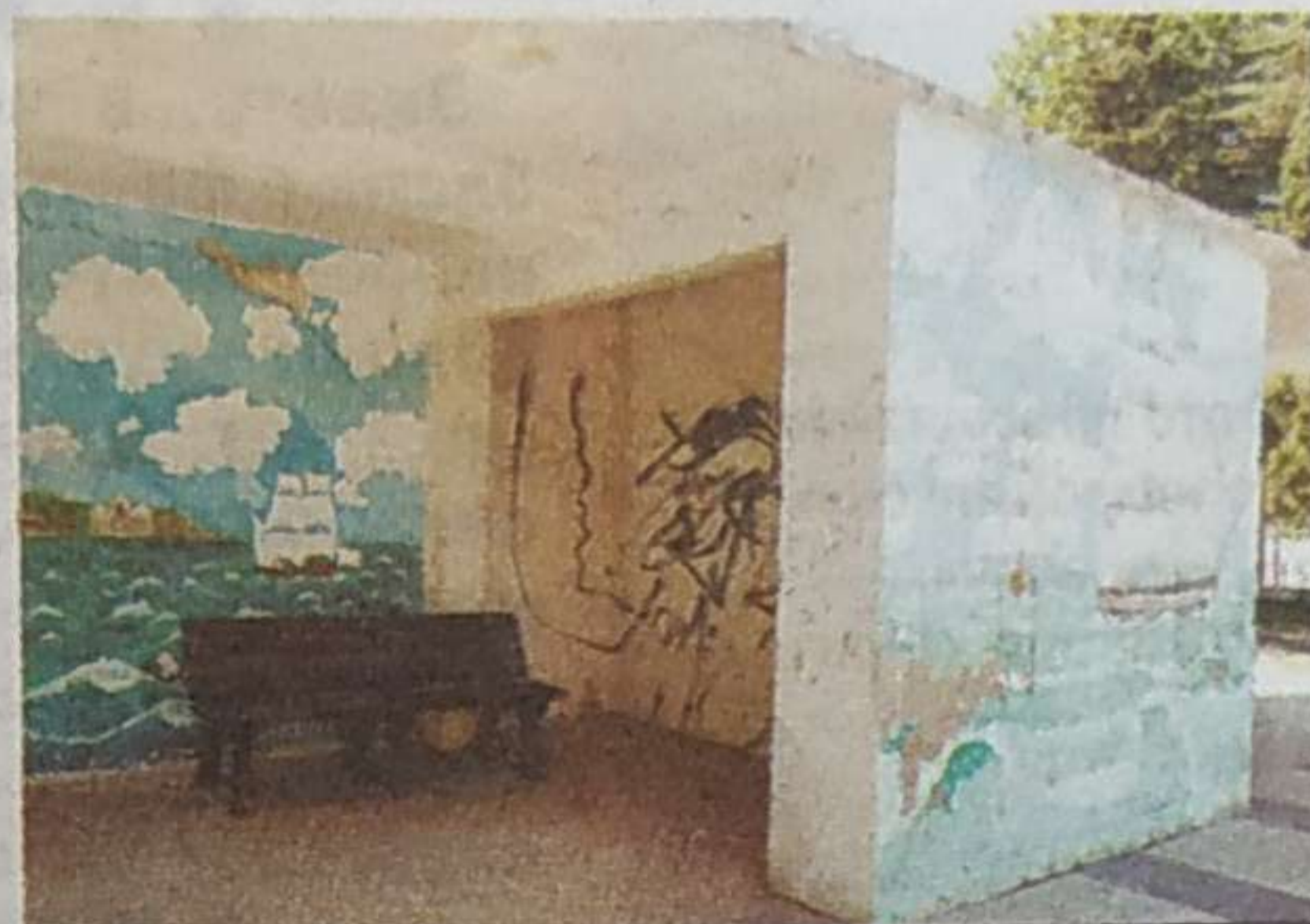
Бетонная остановка - единственное капитальное строение в округе.
